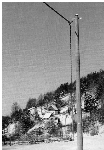
Линия СИП среднего напряжения с поддерживающим зажимом на повороте
