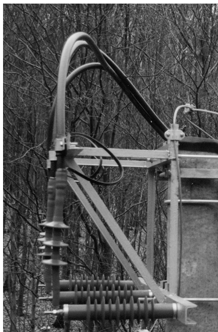
Концевая муфта на линии СИП до 42 кВ, смонтированная наконечниками вниз, для подключения к выключателю
