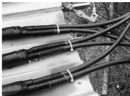
Ответительные муфты на линии СИП до 42 кВ
